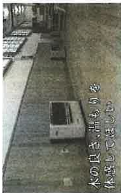
森林環境交付金事業により県産杉材により整備された床板と腰板
